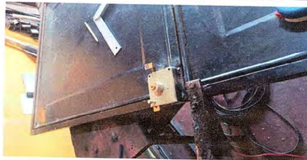
Foto 2: Reparación puerta de baños
