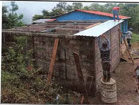
Foto 1: Inicio en colocación de techo de Cocina.
