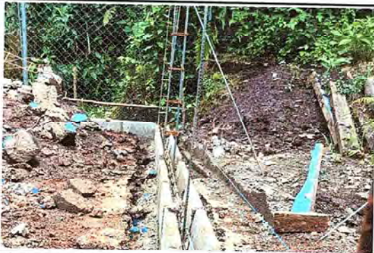
Foto 1: Levantamiento de pared para cocina.
