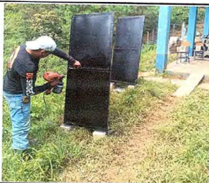
Foto 1: Pintura de puertas
