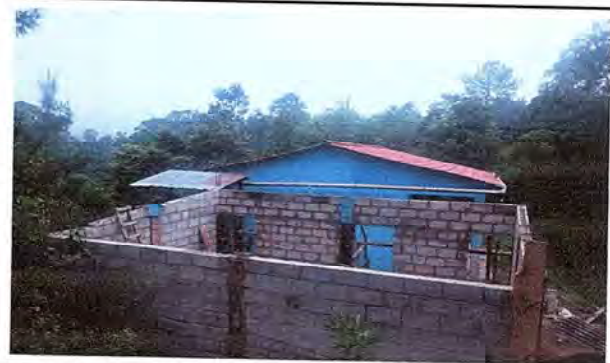
Foto 2: Avance en levantamiento de pared de Cocina.
