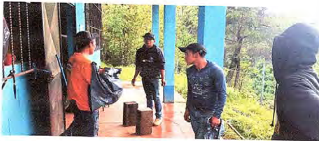
Foto1: Acarreo de materiales para continuar con las actividades de remozamiento.
